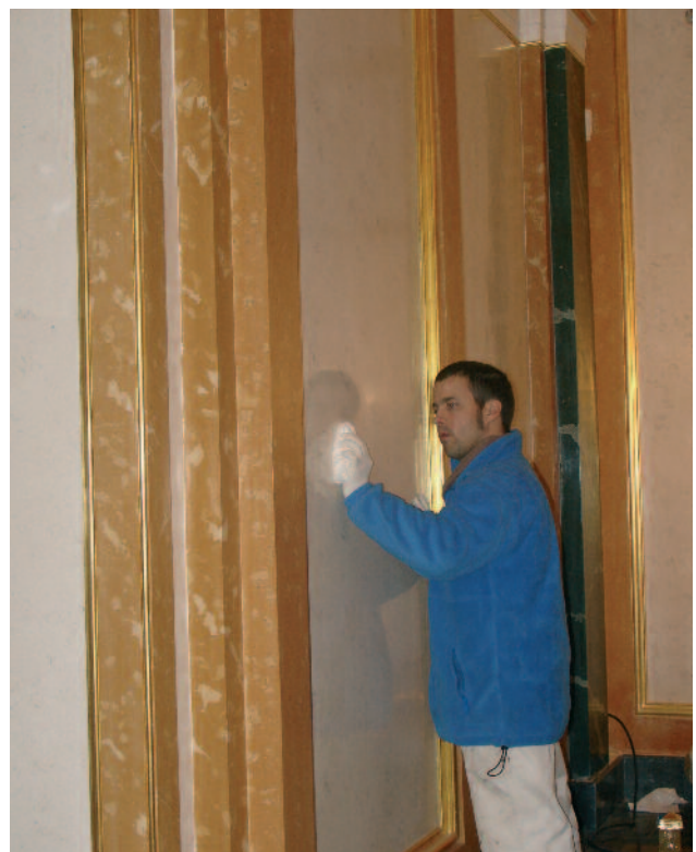
Trabajos de conservación
