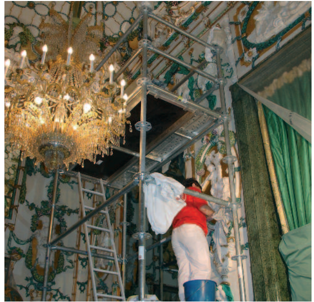
Limpieza y conservación en el Palacio Real de Madrid
