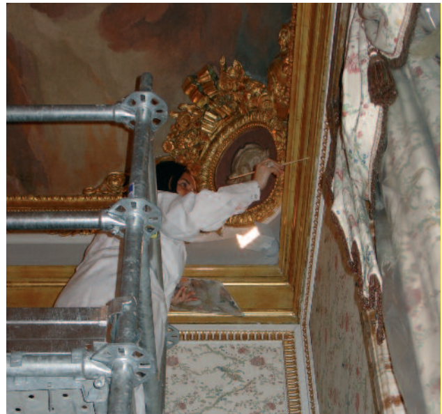
Intervención de urgencia por filtraciones
