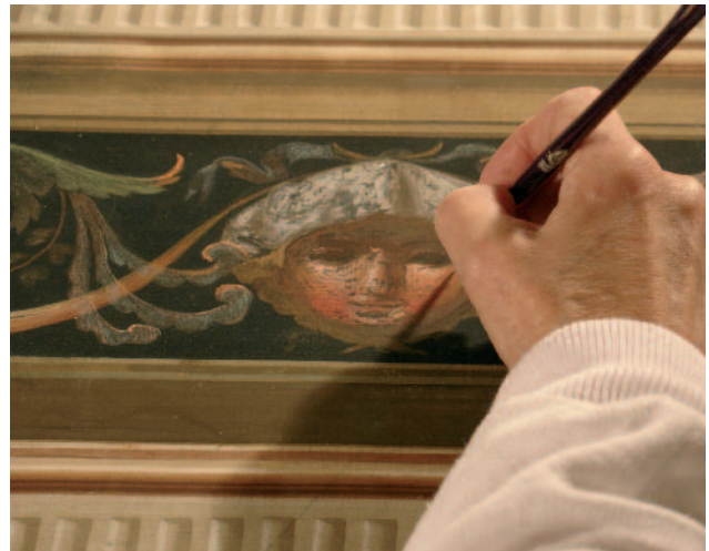
Trabajos de conservación preventiva
